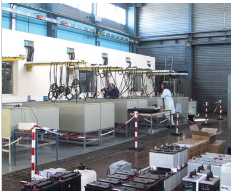
Hall d'essais, à Cadarache, où le CEA étudie le comportement et l'optimisation des batteries couplées avec les modules photovoltaïques.
